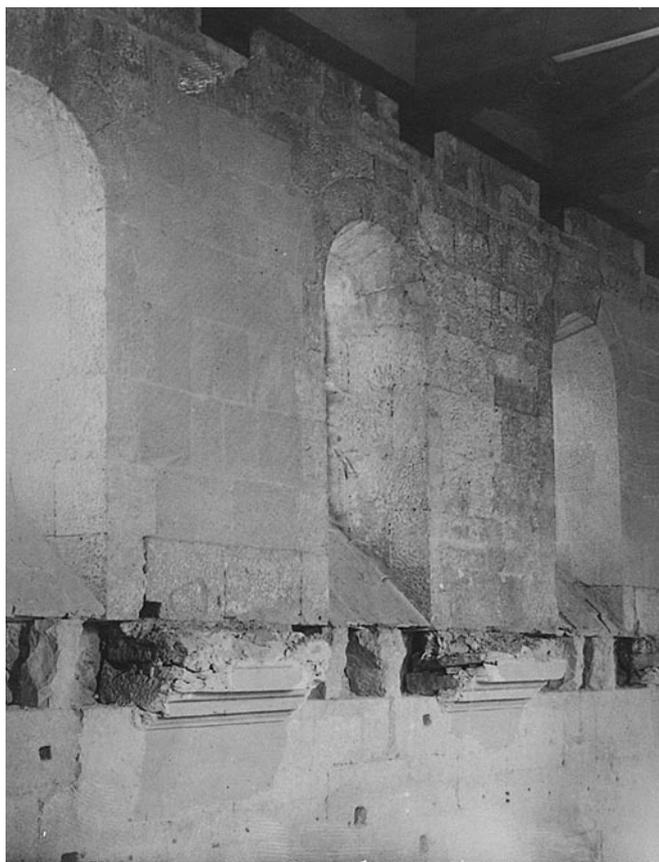
Fig. 14. L'ordine superiore della navata centrale durante i lavori di rimozione delle decorazioni. È possibile apprezzare il rifacimento di parte della muratura in corrispondenza della prima monofora e dello stipite destro della terza (Archivio fotografico della Soprintendenza di Siracusa).
