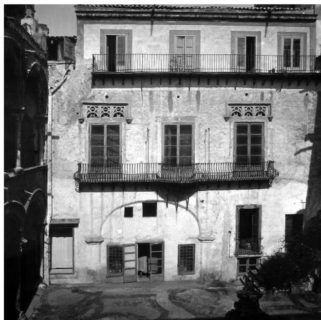
Fig. 3. Palermo. Palazzo Abatellis, prospetto nord-ovest sulla corte. Il progetto comporterà la demolizione del secondo piano, lo smontaggio dei balconi, lo scrostamento degli intonaci, la chiusura delle aperture e la liberazione del compagno dall'arco d'ingresso da via Alloro (Archivio fotografico SBBCCAAP).
