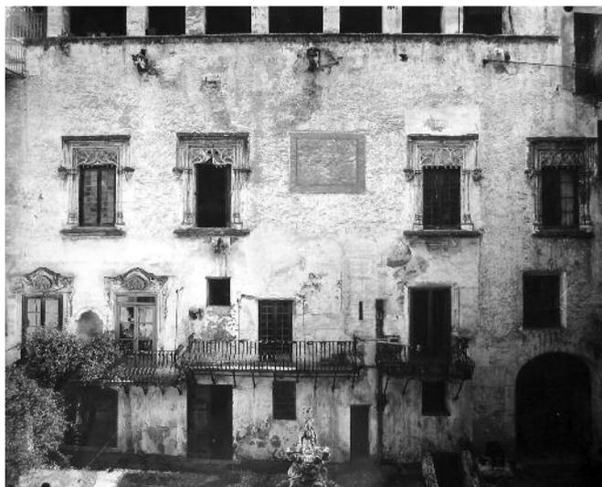
Fig. 4. Palermo. Palazzo Abatellis, prospetto nord-est della corte in cui è evidente la suddivisione interna del piano terra e in basso a destra la trasformazione dei livelli in prossimità del grande arco, con la presenza di un piano seminterrato e delle fontane addossate al prospetto (Archivio fotografico SBBCCAAP).
