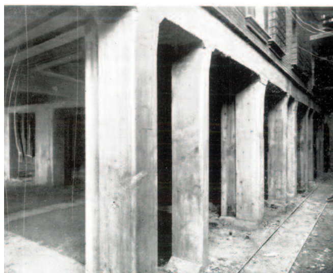
Fig. 13. Venezia. Fondaco dei Tedeschi, la nuova struttura portante in c.a. e, in alto, il particolare della medesima facciata prima dell'intervento (da G. V. Ravà, 1936).
