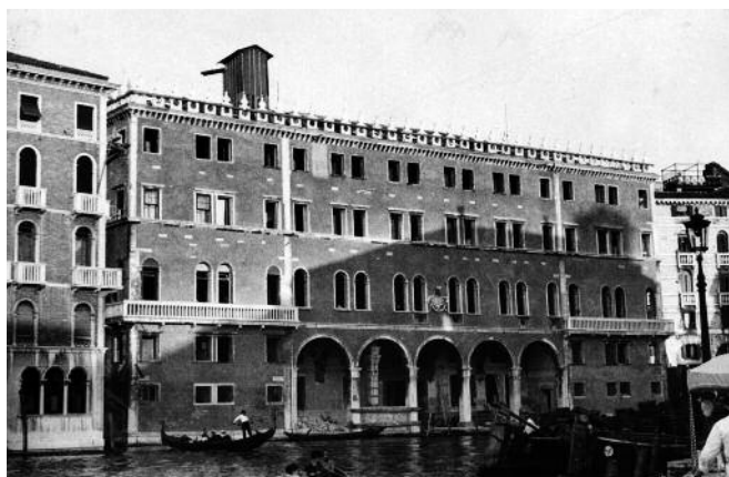
Fig. 12. Venezia. Fondaco dei Tedeschi, prospetto sul Canal Grande nel corso dell'intervento di restauro (IUAV, AP, FFT, 68637-14, album "Restauri statici importanti").
