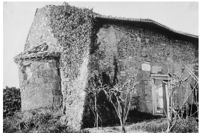
Fig. 13. Palestrina (Roma). San Giovanni Battista, l'inclinazione dell'abside osservata nel 1928, prima dei restauri dell'anno successivo (ACS, Ministero Pubblica Istruzione, Direzione Generale Antichità e Belle Arti, Divisione II, 1929-1932, b. 202, fasc. Roma - prov. P.T.).
