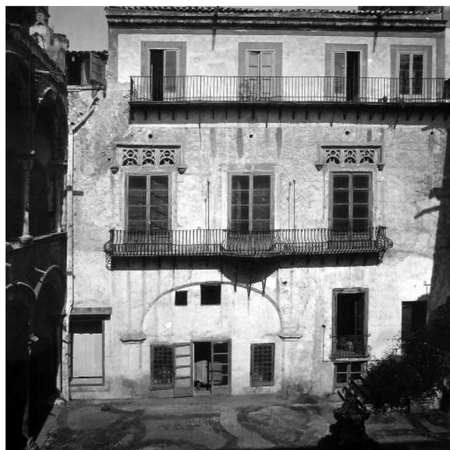
Fig. 3. Palermo. Palazzo Abatellis, prospetto nord-ovest sulla corte. Il progetto comporterà la demolizione del secondo piano, lo smontaggio dei balconi, lo scrostamento degli intonaci, la chiusura delle aperture e la liberazione del tempagno dall'arco d'ingresso da via Alloro (Archivio fotografico SBBCCAAP).
