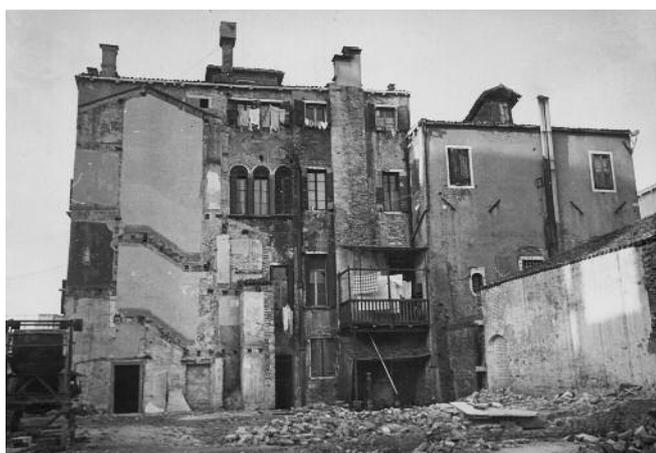
Figg. 10-11. Venezia. Palazzo Adoldo, le opere di messa in sicurezza della facciata e la demolizione del corpo aggiunto (IUAV, AP, FFT, Forlati 2.1 Progetti e concorsi/045).
