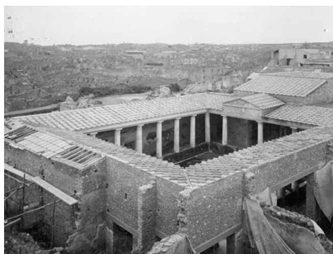
Fig. 5. Pompei. La Casa del Menandro durante i lavori di restauro, 1930 (Archivio Pompei).
