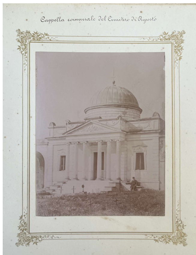
Fig. 8. Cappella comunale del cimitero di Riposto, foto d'epoca (archivio Pietro Grassi Finocchiaro).
