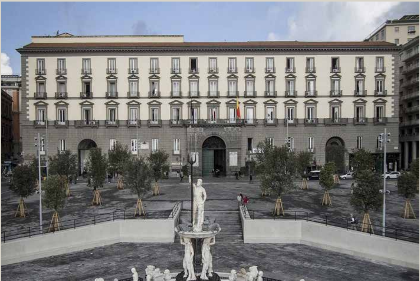
2. Napoli. Palazzo San Giacomo, la facciata inserita nella nuova sistemazione di piazza Municipio, con antistante la fontana di Nettuno, cui segue l'uscita della nuova metropolitana (linee 1 e 6). Public domain
