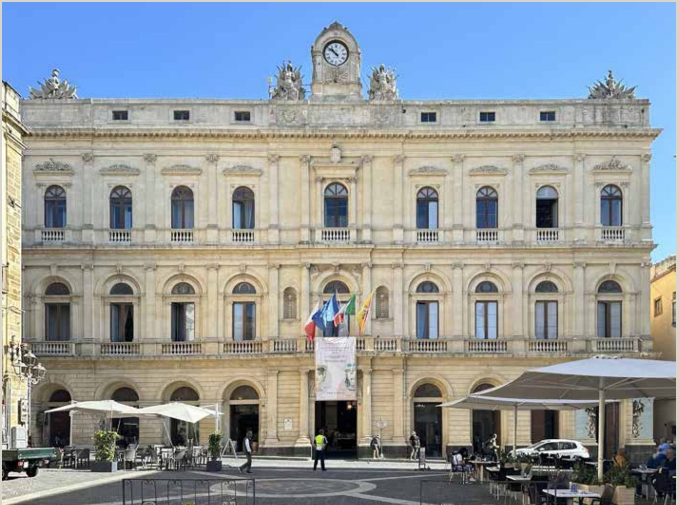
1. Caltagirone. Palazzo comunale, prospetto principale. Foto dell'A.
