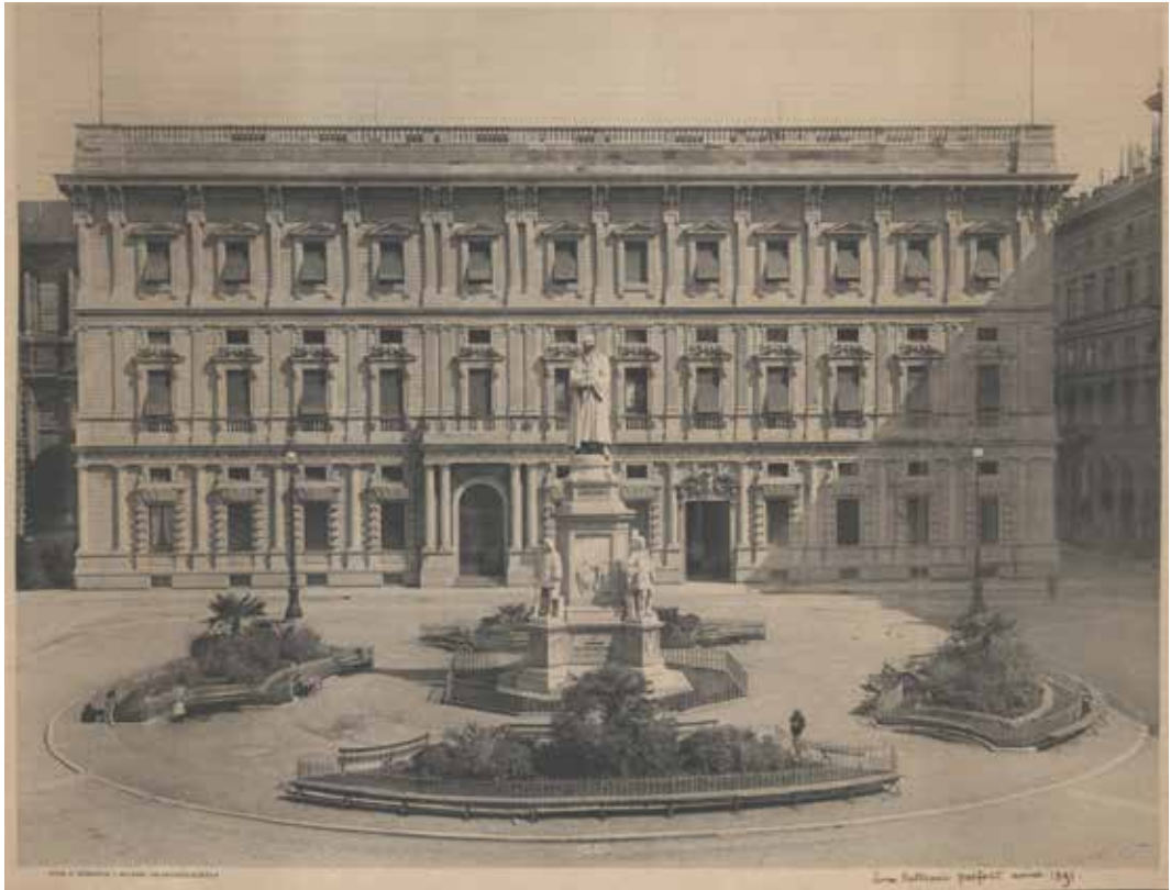
4. Milano. Palazzo Marino, facciata su piazza della Scala, 1890-1891. Fotografia di Arturo Demarchi. Milano, Civico Archivio Fotografico, Raccolta Luca Beltrami, RLB 2954/A.
