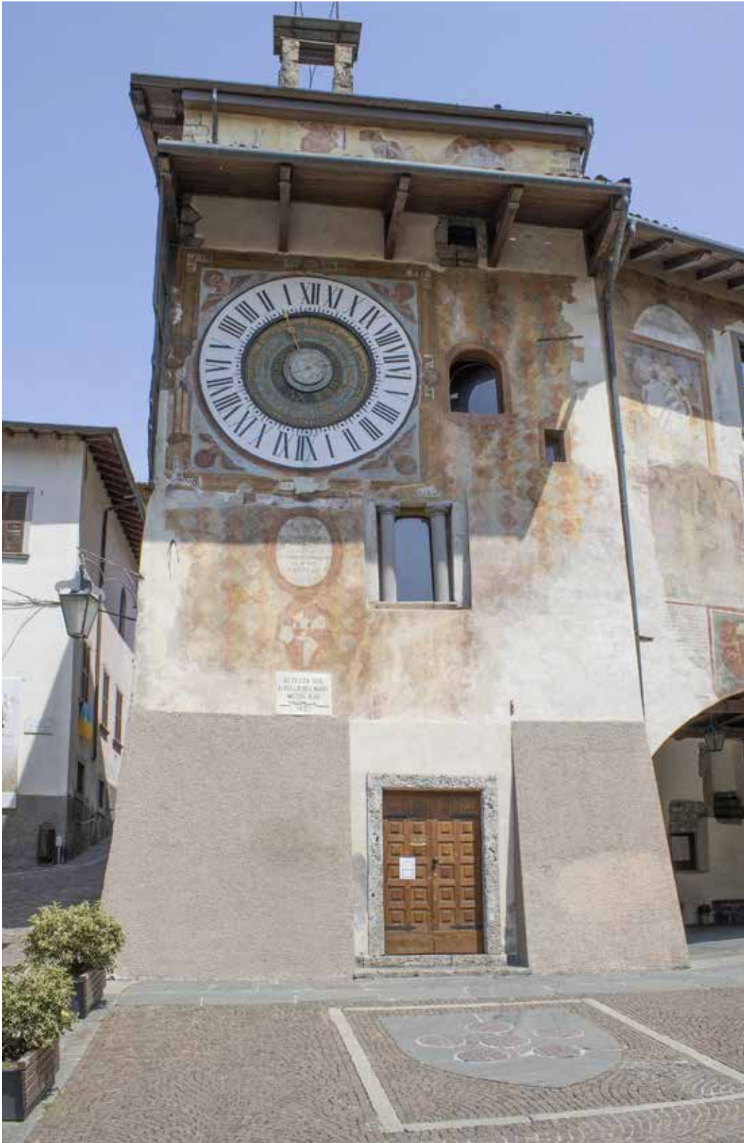
3. Clusone (Bergamo). La Torre dell'Orologio planetario. Foto dell'A.
