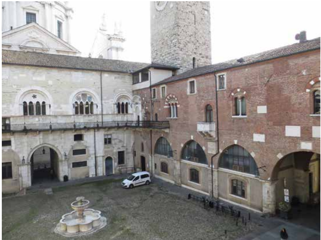
6. Brescia, Palazzo del Broletto, veduta parziale dei prospetti interni del corpo meridionale, verso nord, e del corpo occidentale, verso est. Foto dell'A.
