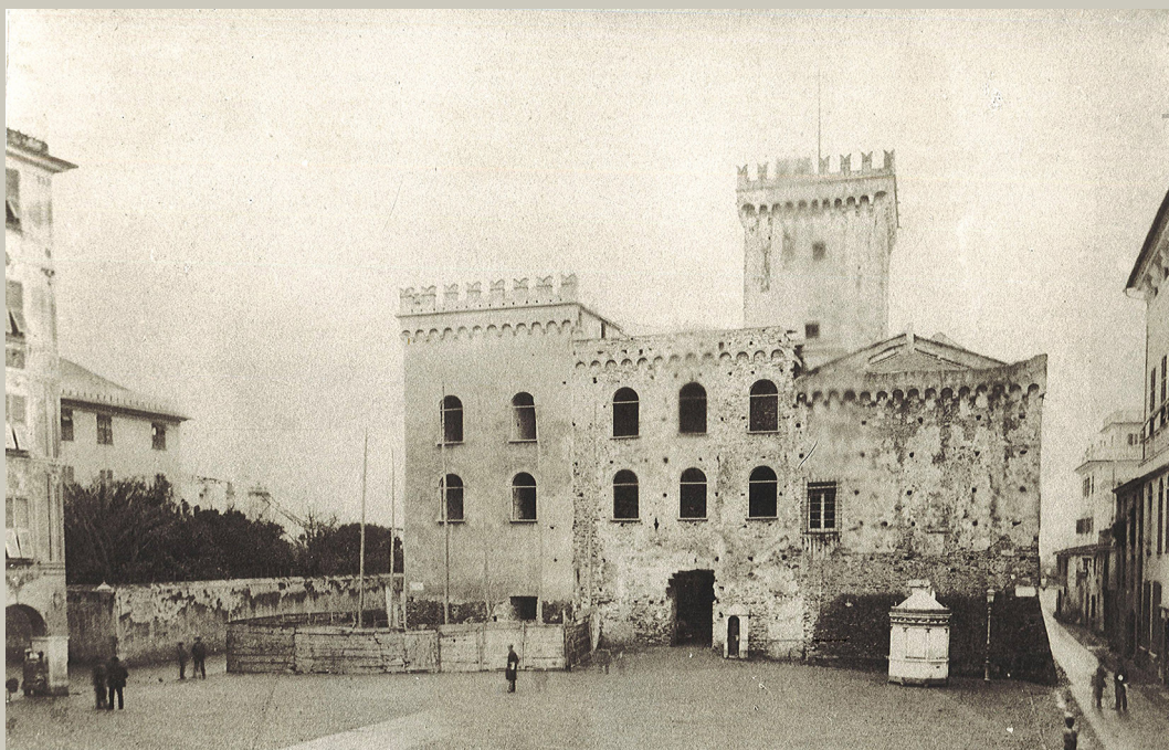
1. Chiavari. La facciata dell'antica Cittadella sulla piazza Carlo Alberto intorno alla metà del XIX secolo. BSEC, fasc. 4F, foto 3, 203.
