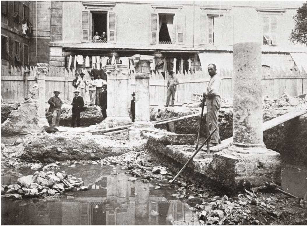
7. La Spezia. I resti della curia tardo-medievale scoperti durante i lavori di demolizione del vecchio Palazzo Cenere, 1902 (Amelio Fara, La Spezia , Roma-Bari, Laterza, 1983, 7).
