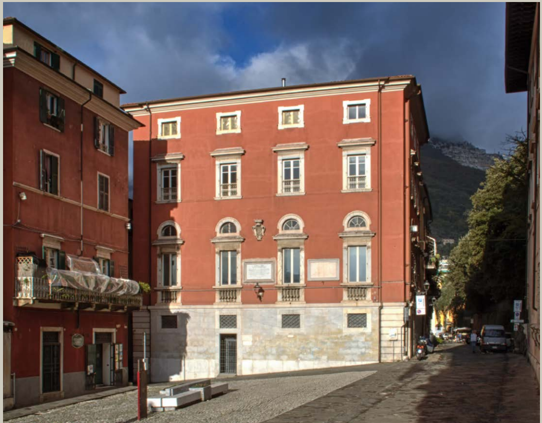
2. Carrara. Palazzo Rosso, prospetto secondario su piazza dell'Accademia. Foto delle Autrici.
