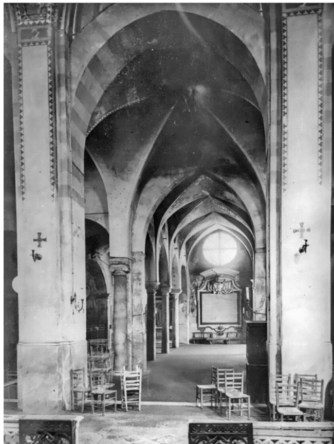
Fig. 7. Napoli, chiesa di San Giovanni a Mare, l’interno della fabbrica prima dei restauri postbellici.
