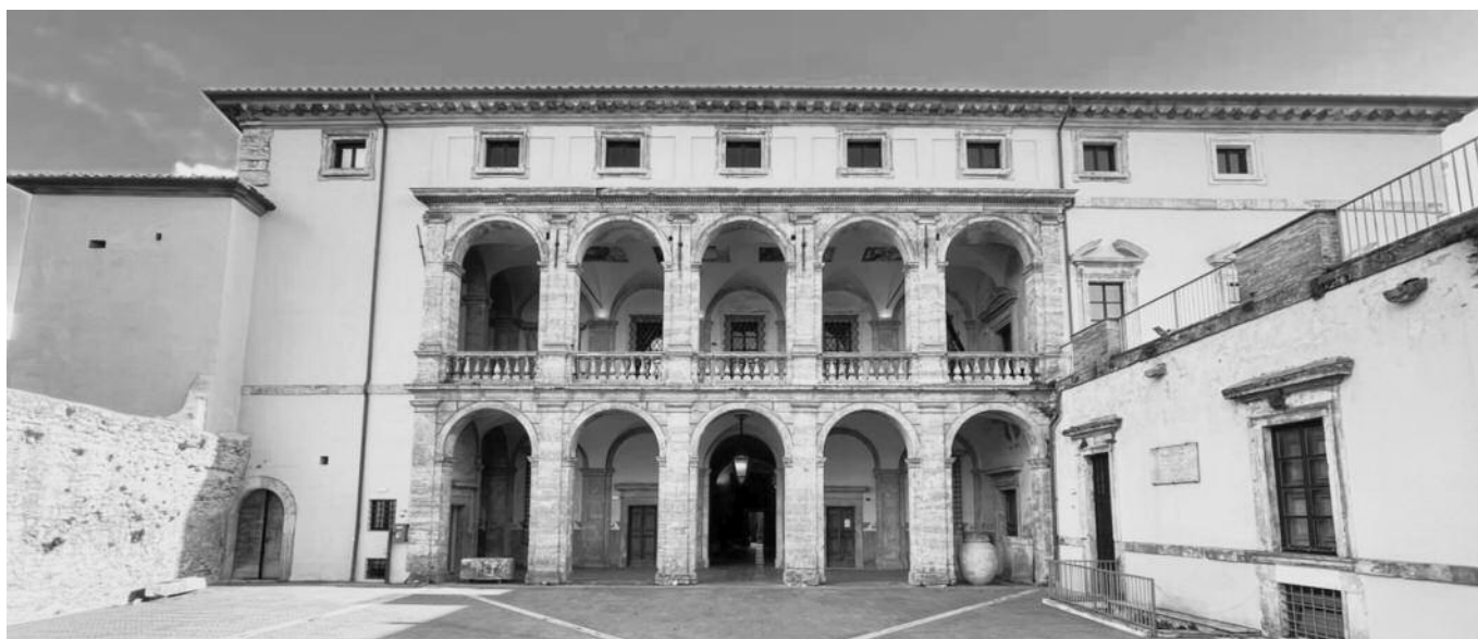
Fig. 12. Acquasparta, loggiato di palazzo Cesi, prospetto sulla corte interna.
