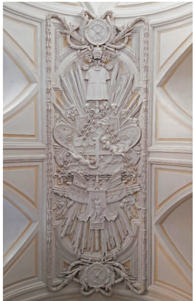
Fig. 4. Roma, Santa Maria del Priorato, stucchi della volta (2020) (Archivio SSABAP Roma).
