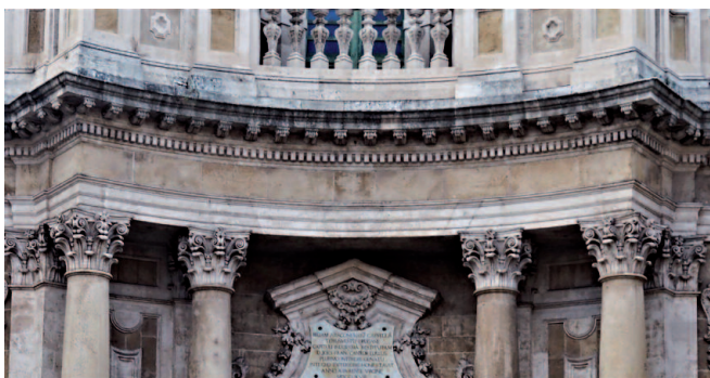
Fig. 4. Catania, chiesa della Collegiata, dettaglio della piattabanda sopra il portale.
