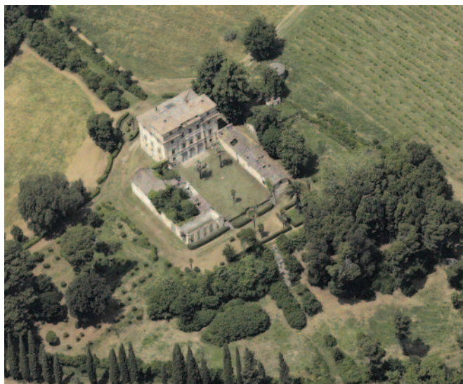
Fig. 3. Terni, veduta aerea del complesso di villa Palma (per gentile concessione F. Canali e G. Castellini Rinaldi).
