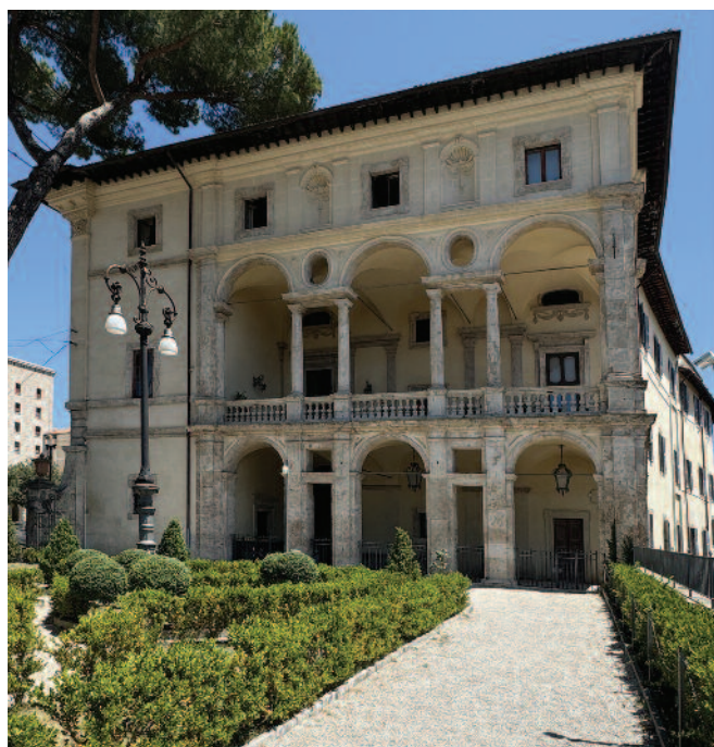
Fig. 13. Rieti, loggiato di palazzo Vincentini (foto dell'autore).
