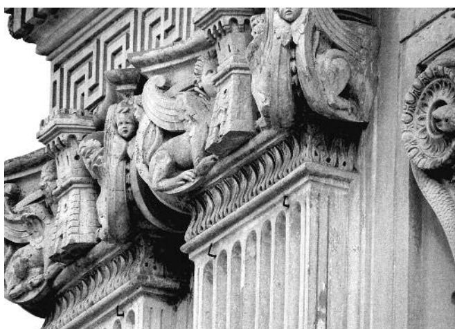
Fig. 14-16. Roma, Santa Maria del Priorato, particolare con gli stucchi della facciata prima e durante l'intervento di restauro del 2017-2019 (foto G. Ferreri).
