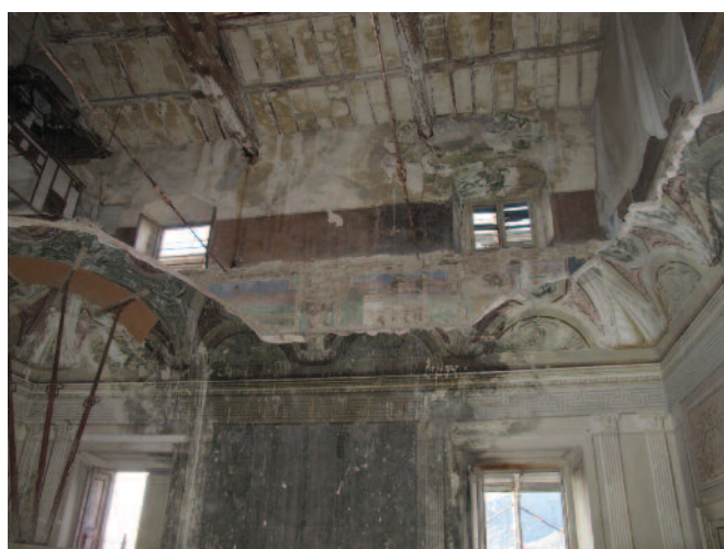
Fig. 7. Terni, volta crollata al piano nobile di villa Palma (foto di G. Castellini Rinaldi, 2018).
