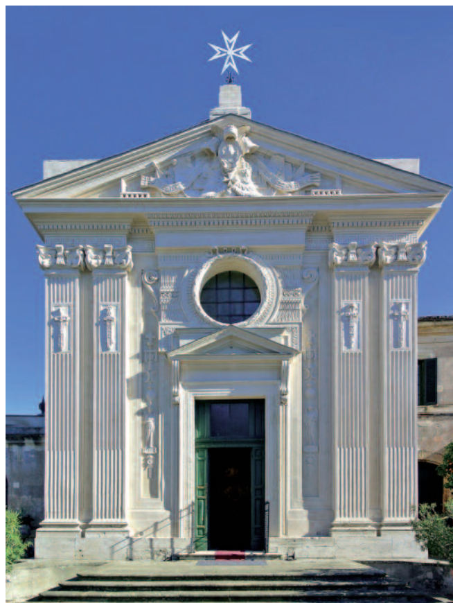
Fig. 8. Giovanni Battista Piranesi, Facciata della chiesa di Santa Maria sul Monte Aventino, Roma, 1764-67. Foto di Carolina Marconi.
