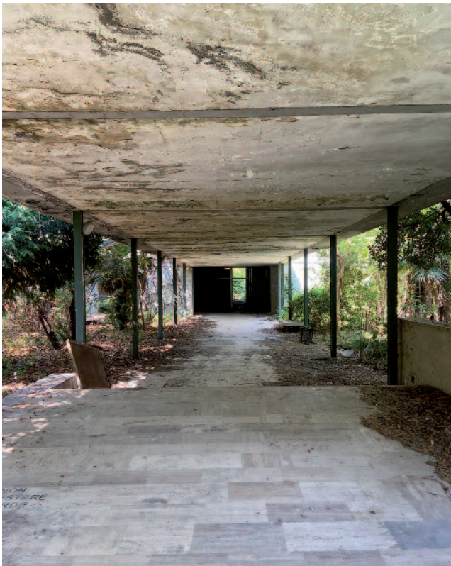
8_Dettaglio delle pensiline d'ingresso al complesso delle cure idropiniche. 9_biglietteria complesso delle cure idropiniche.
