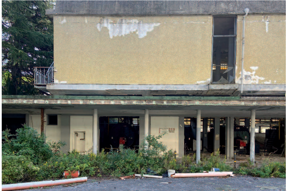
7_Centrale termica, situato nella area della balneoterapia.
