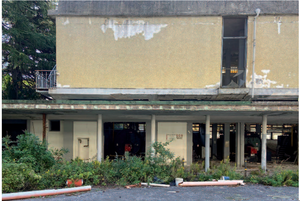
7_Centrale termica, situato nella area della balneoterapia.
